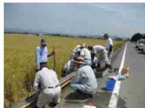
水路を自主施工で補修作業
